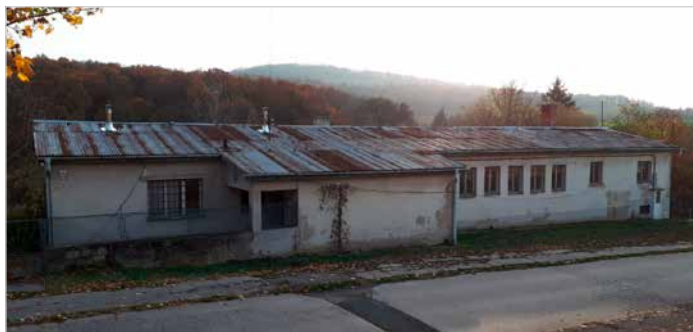
Budova Komunitného centra pred rekonštrukciou
