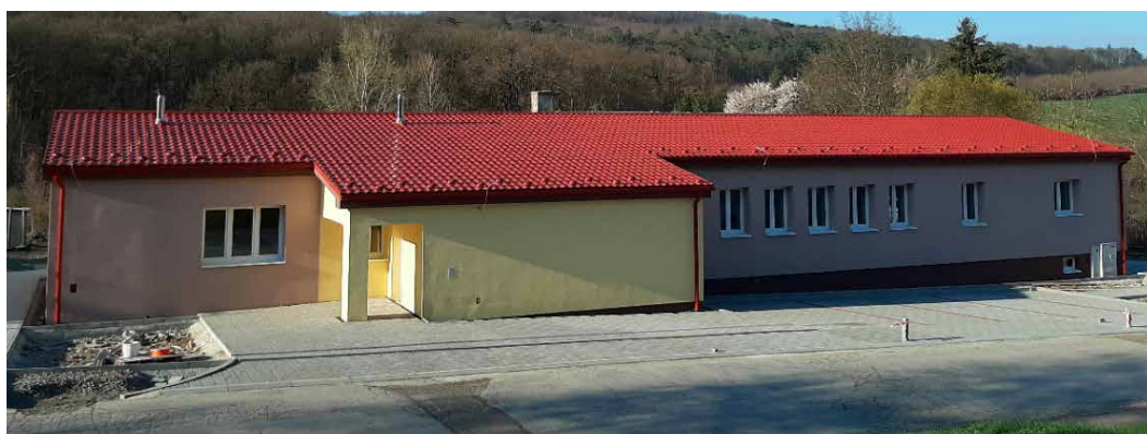
Komunitné centrum po dokončení stavebných prác
