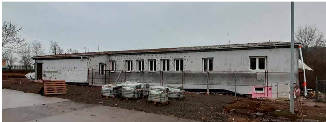
Komunitné centrum - počas rekonštrukcie
