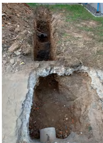
Oprava kanalizácie a jej odvodnenie
