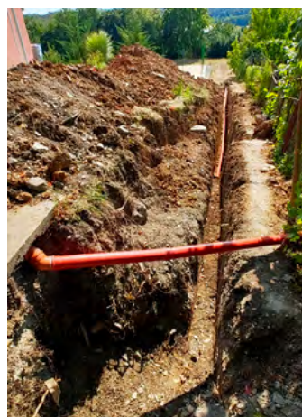
Oprava kanalizácie a jej odvodnenie
