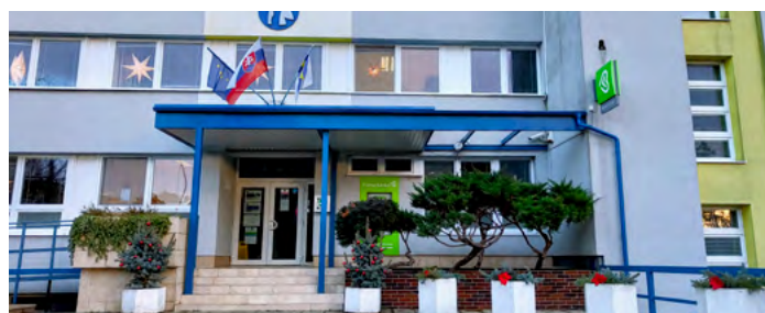
Výmena strechy nad vchodom do mestského úradu
