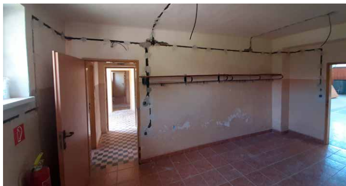
Rekonštrukcia havarijného stavu telocvične ZŠ
