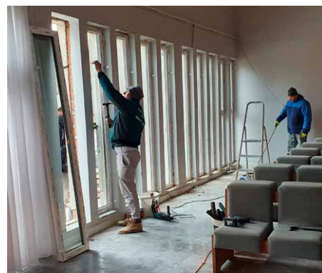
Výmena okien v Dome smútku na Lipníku
