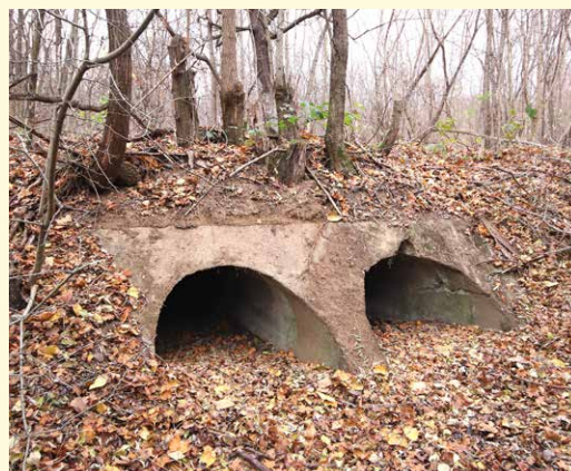
Zachovaný železničný násyp s priepustom.
